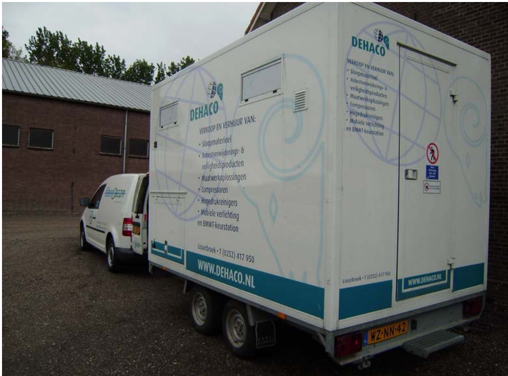
Foto 1: Een decontaminatieunit voor werkzaamheden met asbesthoudende producten.
