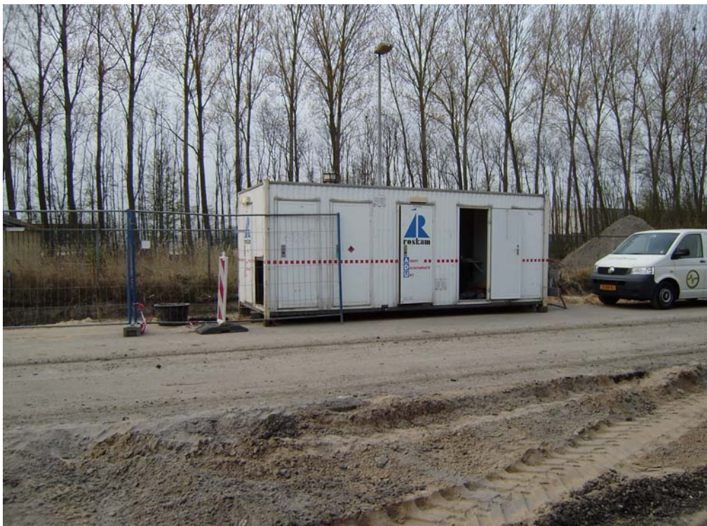
Foto 2: Een decontaminatieunit in gebruik als schoon-vuilunit.
