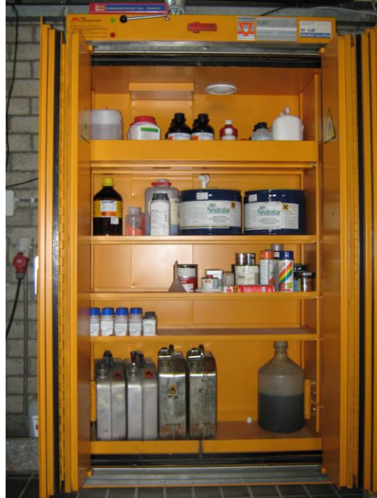
na opruimen en compartimenteren
