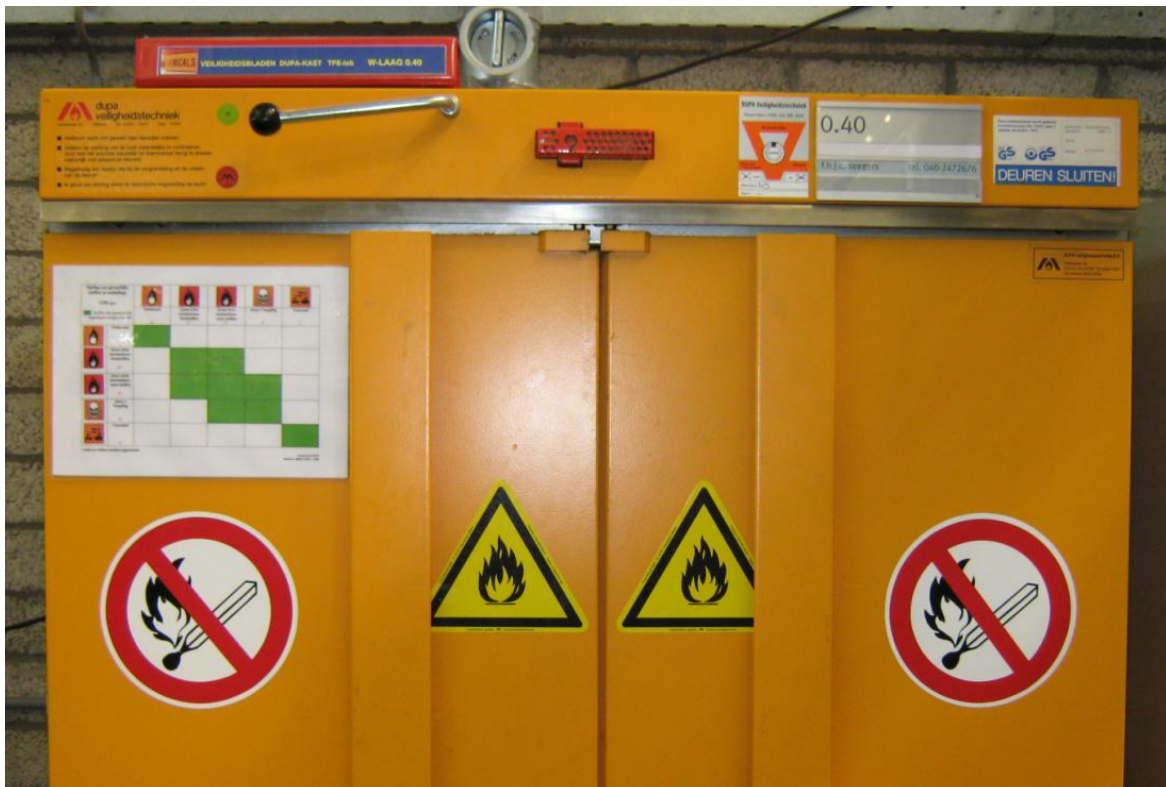
Figuur 2: CPR 15-1 Schema en gevaarsymbolen op een veiligheidskast
