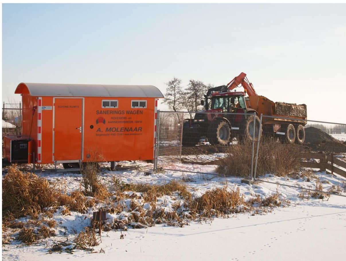
Aanbrengen van schone grond na vrijgave door MKB, januari 2013
